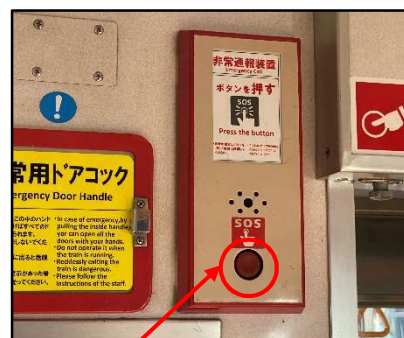
非常通報ボタン
