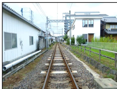
(PCマクラギ化工事 左：着手前 右：完成後)
