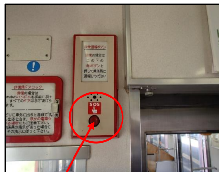
非常通報ボタン
